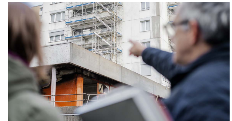
Diverse benachbarte Gebäude wurden in Mitleidenschaft gezogen.
