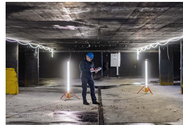
Die Tiefgarage wird von Mathias Cotti begutachtet.
